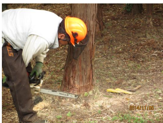
ヒノキの伐採作業に入る。先ず、受け口に刻みを入れる。追い口は反対側。チェーンソーで瞬く間に樹木は切り倒された。
